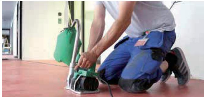
Motore potente idoneo a lavorare rivestimenti in PVC, PUR e linoleum.
