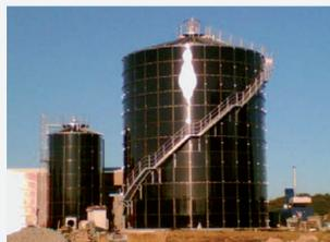
Serbatoio di miscelazione, digestore
