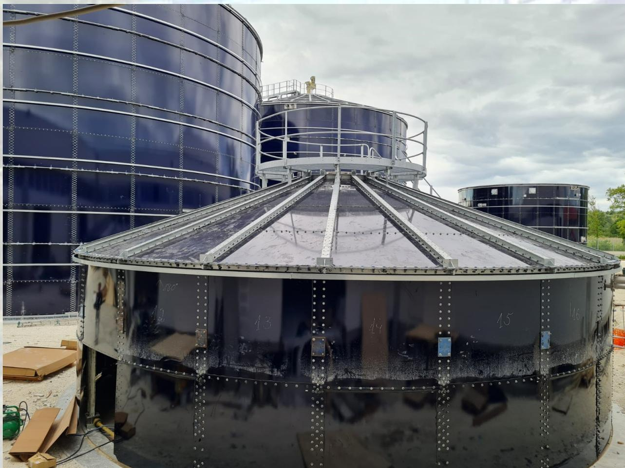
***Bau Emme in cooperazione con Gruppo Astea ha scelto i serbatoi GLS per un impianto FORSU per la produzione di biometano per autotrazione, Ostra (AN), 2021***
