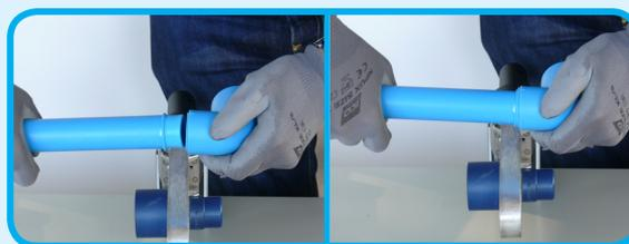
Trascorso il tempo di riscaldamento prescritto, inserire rapidamente il tubo nel raccordo senza ruotare praticando una leggera pressione.
