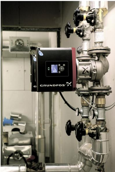
La TPE3 è dotata di sensore di temperatura integrato che permette alla pompa di adattare le proprie prestazioni in funzione della temperatura dell'acqua.
