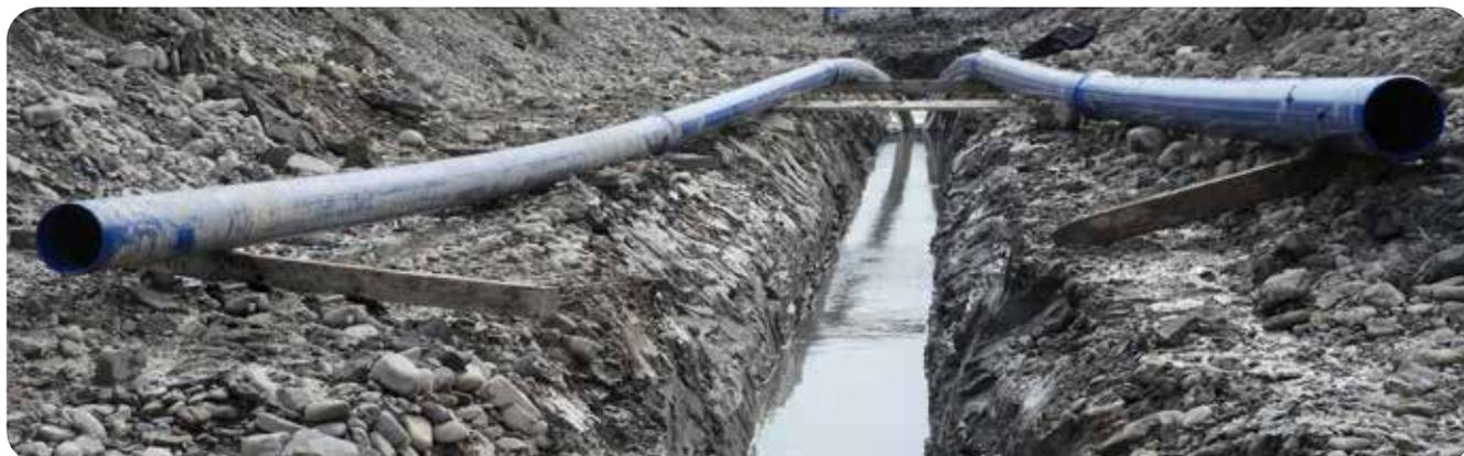
La tecnologia **FITT Bluforce RJ** aggiunge la resistenza alla trazione alle già note caratteristiche del FITT Bluforce: a parità di diametro esterno la sezione idraulica del **FITT Bluforce RJ** è migliorativa rispetto agli altri termoplastici normalmente utilizzati per il trasporto di acqua potabile in pressione;
