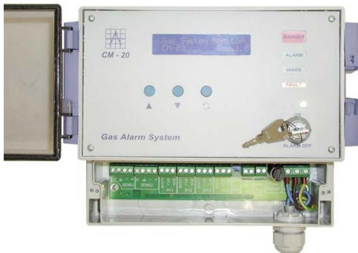
Le Unità CM-10 e CM-20 hanno rispettivamente uno e due canali d'ingresso, sono centraline programmabili ideate per operare con trasmettitori gas remoti con segnale 4-20mA.
