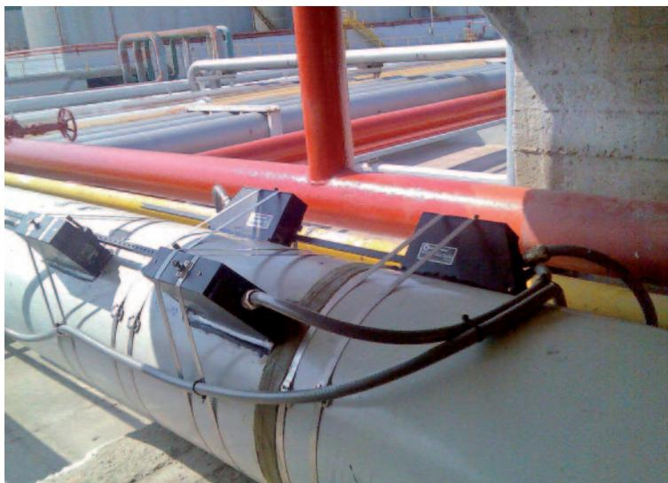
parete del tubo diventi una "guida d'onda", cioè un'estensione del trasduttore stesso.
