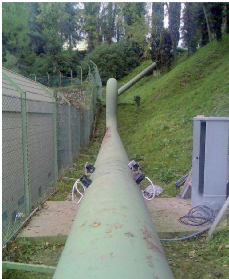
guenza non può fornire una misura affidabile alle basse portate, ma permette di controllare il flusso quando non è possibile con il metodo a tempo di transito, perché il fluido è fangoso o molto aerato. Le prestazioni dello strumento soddisfano molteplici condizioni idrauliche e impiantistiche, sia con misuratori portatili sia in versione dedicata sempre con montaggio esterno non intrusivo.
