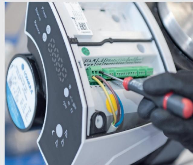
4. ESEGUIRE il collegamento elettrico con tensione monofase.
