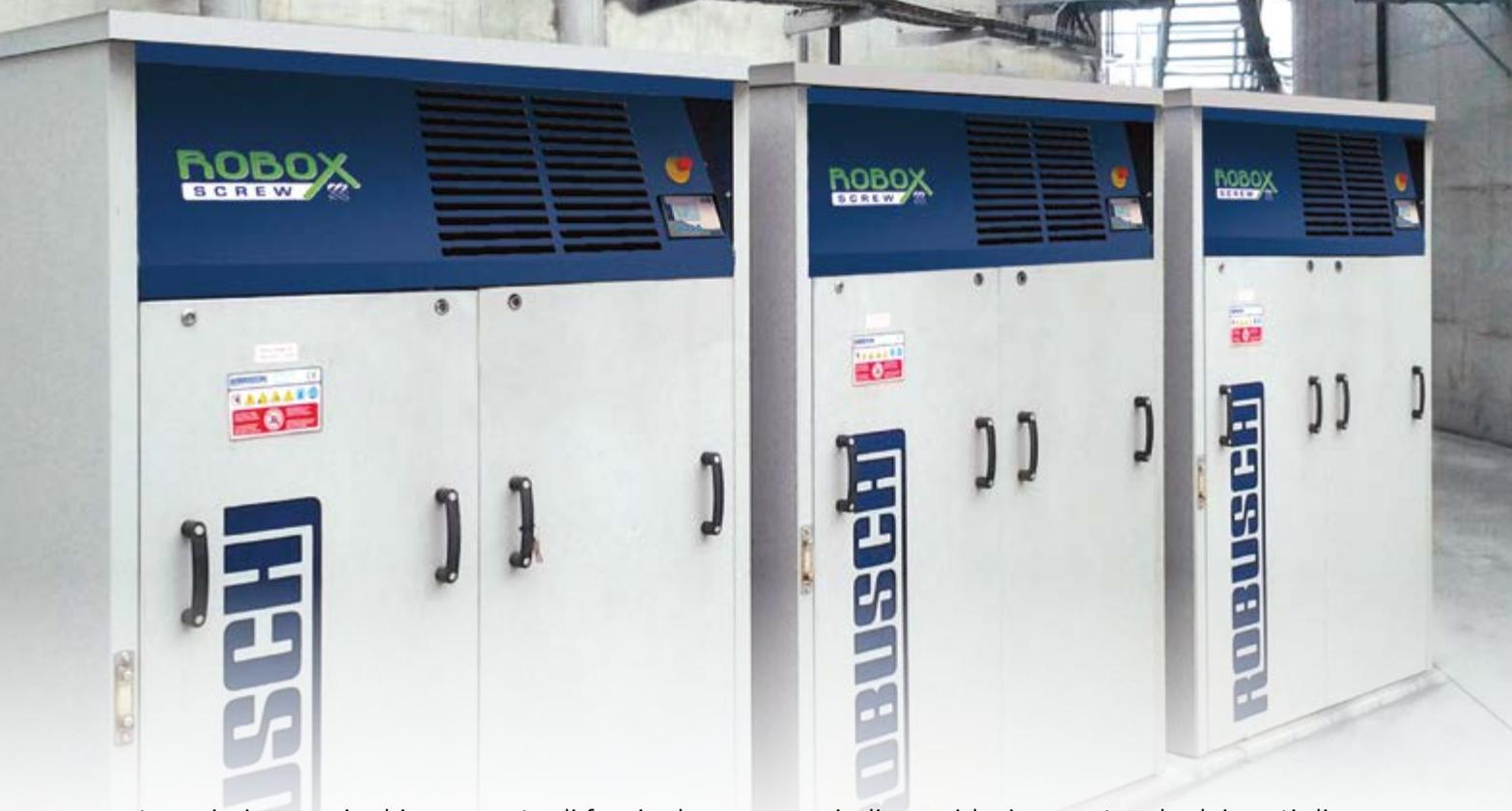
trasmissione a cinghia consente di fornire la corretta portata richiesta dall'applicazione ed inoltre permette di installare il motore più adatto alla potenza assorbita dal compressore con conseguente funzionamento nel punto di maggior rendimento.
