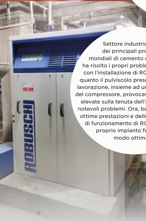
Settore industriale: uno dei principali produttori mondiali di cemento ed aggregati ha risolto i propri problemi di impianto con l'installazione di ROBOX screw, in quanto il pulviscolo presente nelle fasi di lavorazione, insieme ad un'elevata velocità del compressore, provocavano temperature elevate sulla tenuta dell'albero, creando notevoli problemi. Ora, beneficiando delle ottime prestazioni e delle basse velocità di funzionamento di ROBOX screw, il proprio impianto funziona in modo ottimale.
