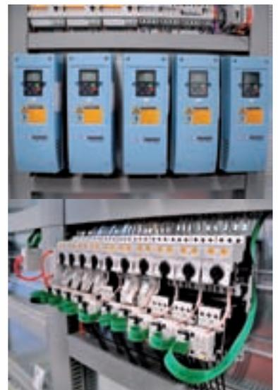
▲ Gli interruttori protezione motore PKE connessi al sistema SmartWire-DT consentono un'efficace diagnostica a distanza con un cablaggio ridotto
