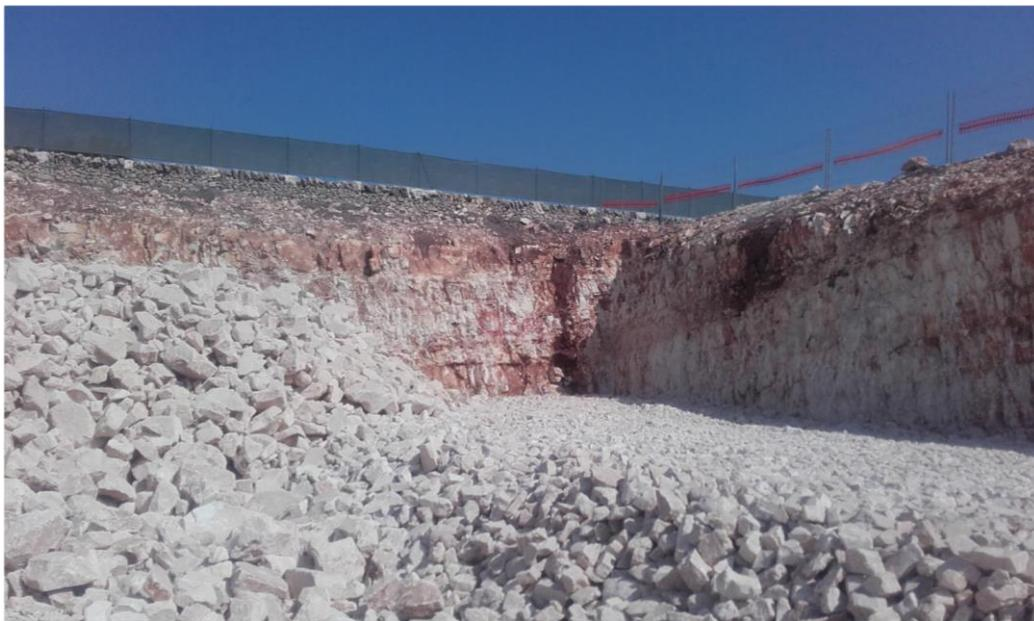
*Operazione di riempimento ecofiltro con materiale vagliato*
