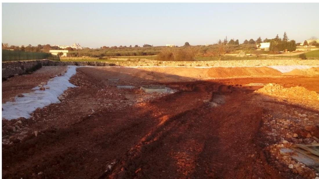
*Operazione di copertura ecofiltro con geotessile e terreno*
