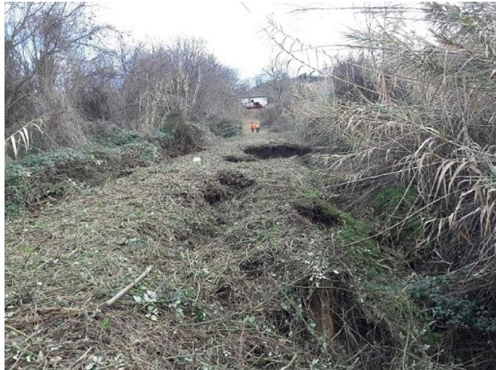
*Foto 1 - Percorso del Sifone fiumara Venosa sino alla camera di Valle, con evidenza dei dissesti del terreno dovuti alle cospicue perdite*
