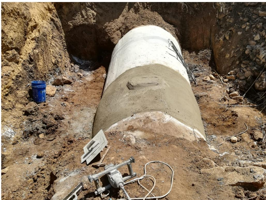
*Foto 9 - Riparazione di lesioni diffuse dall'esterno con resine colabili e rinforzo condotta con malte cementizie e armatura di rete in fibr*
