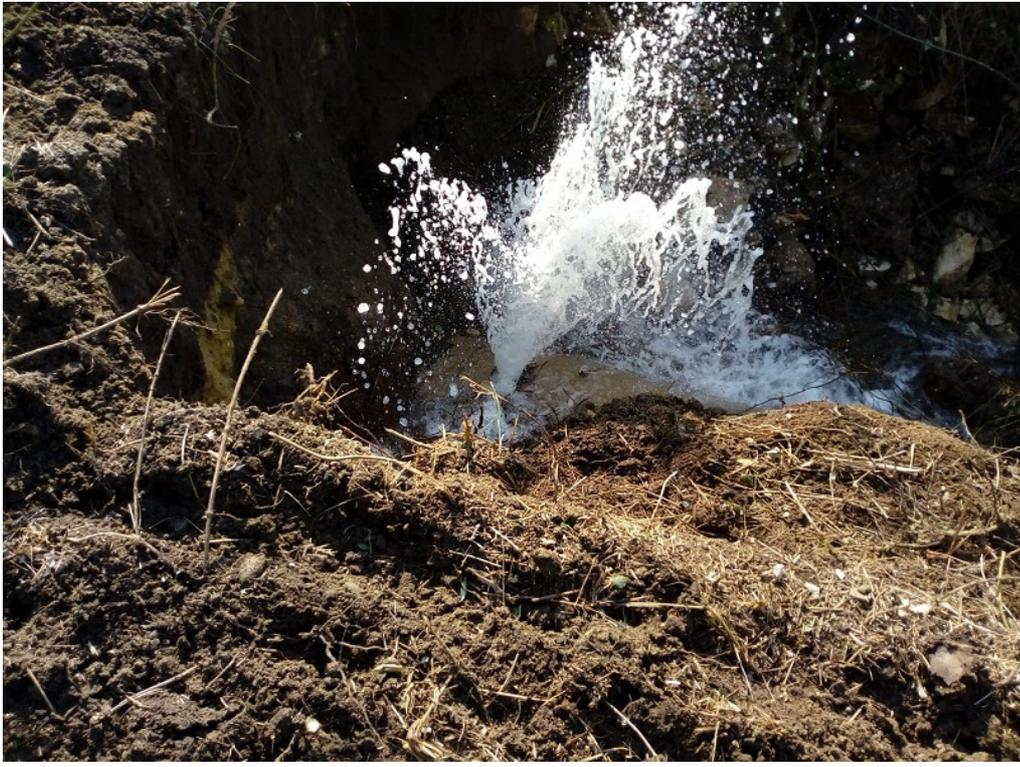
*Foto 3 - condotta scoperta con evidenza della perdita idrica*
