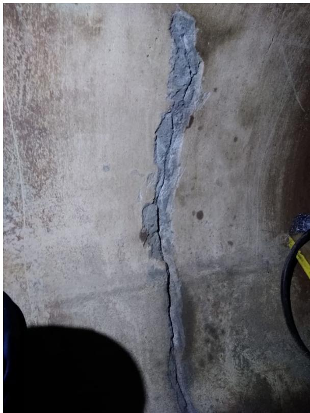
*Foto 6 - Lesione in evidenza dall'interno della condotta*
