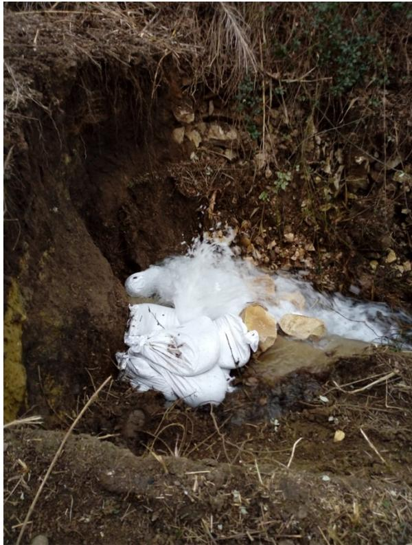
*Foto 4 - contenimento temporaneo della perdita con sacchi di sabbia*
