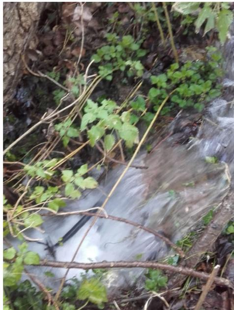
*Foto 2 - perdita idrica emersa in superficie*
