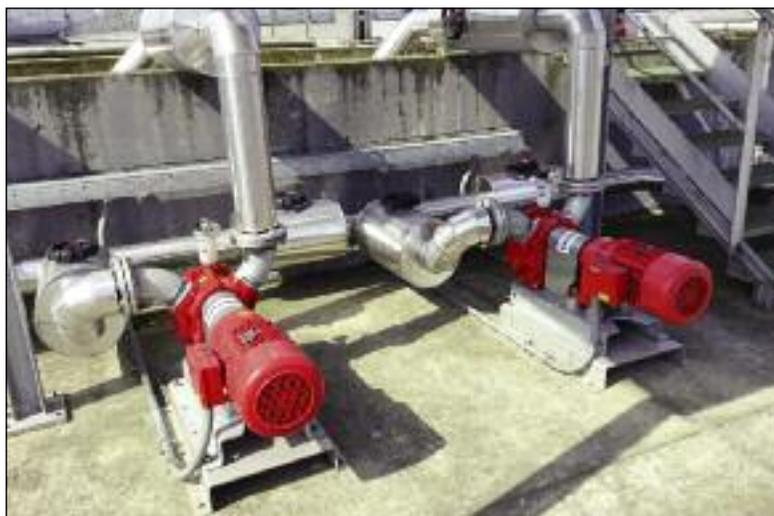
perché la notevole capacità autoadescente, fino a 9 metri teorici, risulta preziosa in una situazione in cui le schiume sono per la maggior parte sotto il livello stradale. Le pompe sono state posizionate tra i pozzetti e dotate di un sistema di valvole e rinvii che permette, in caso di necessità, di gestire due pozzetti con uno stesso dispositivo. Per l'attivazione automatica in caso di aumento del livello delle schiume è stato
