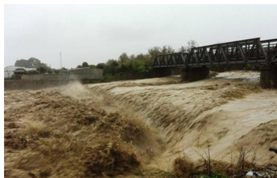
Allarmi antiesondazione fiumi
