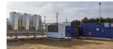
Nel dettaglio, continua la nota, l'intesa include tre impianti da 350 Smc/h, uno da 450 Smc/h e uno da 900 Smc/h, tutti equipaggiati con tecnologia AB BIOCH4NGE, sistema di upgrading a membrane ad alta selettività: ogni impianto sarà dotato di sistemi accessori per il trattamento completo e l'immissione del biometano nella rete nazionale.
